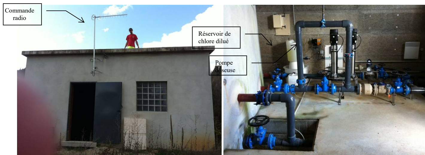
Réservoir de Marance
